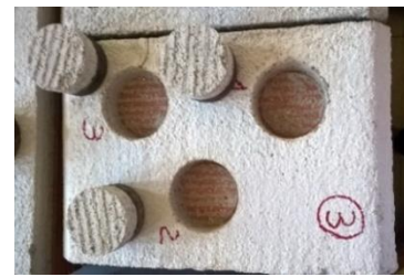
Figura 3.30: Rotura adesiva nos carotes após arrancamento
